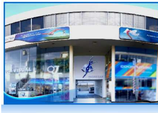
Figura 5. Instalaciones físicas actuales de la Clínica Capilar y de Estética Láser
