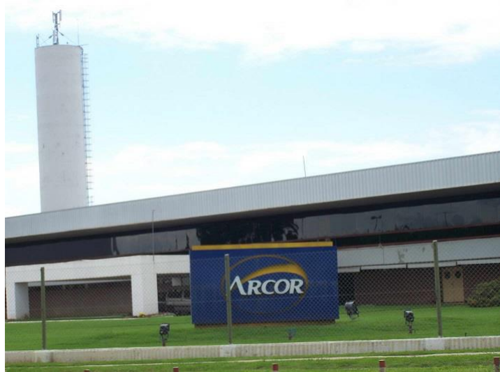
Figura No.1: Planta Industrial ARCOR - RN 148 Km 756,7 5730 Villa Mercedes, Prov. San Luis.
