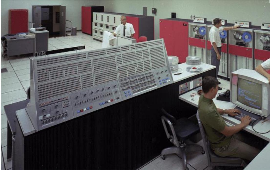
*Ilustración 1 Computadora IBM System/360, primer equipo en ser utilizado para virtualización en la década de 1960.*
