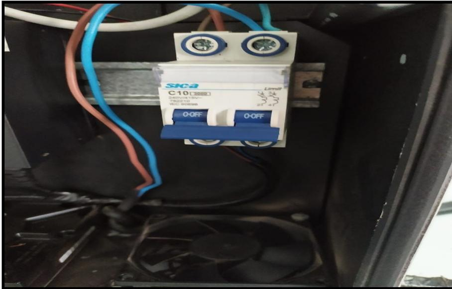
Interruptor termomagnético bipolar para proteger el equipo ante cortocircuitos.
