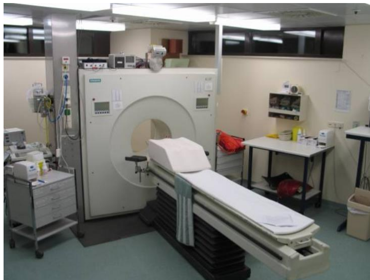
Figura 18: Imagen de una instalación típica de PET equipada con un escáner [23]
