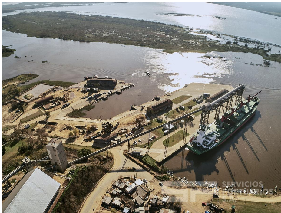
Imagen 5 Vista aérea del muelle del CGPSP
