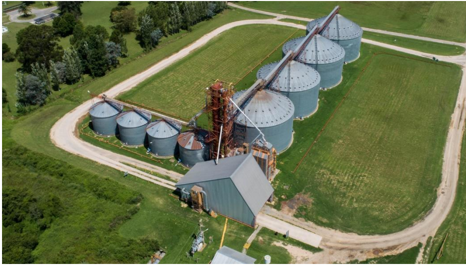
Imagen 10 Silos Delta Dock
