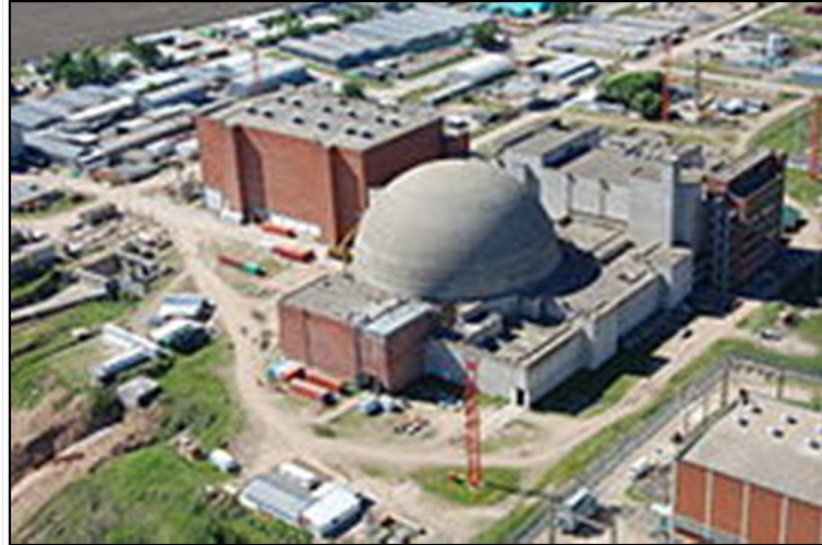
Figura 8: Central nuclear Atucha II Fuente: Nucleoeléctrica Argentina S.A.
