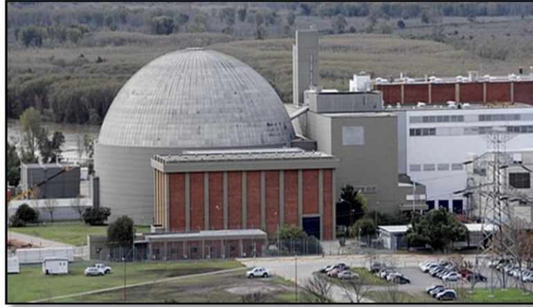
Figura 6: Central nuclear Atucha UI Fuente: Nucleoeléctrica Argentina S.A.
