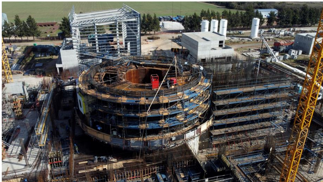
Figura 9: Proyecto Carem Fuente: Nucleoeléctrica Argentina S.A.
