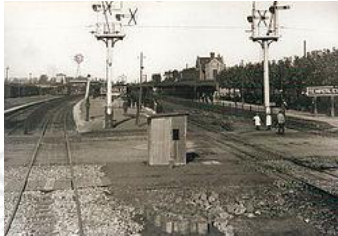
Señalizaciones de la Estación Temperley. 1925
