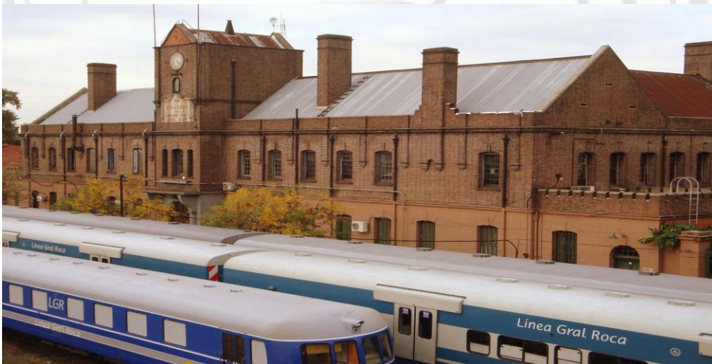
Talleres de Remedios de Escalada (línea Roca)
