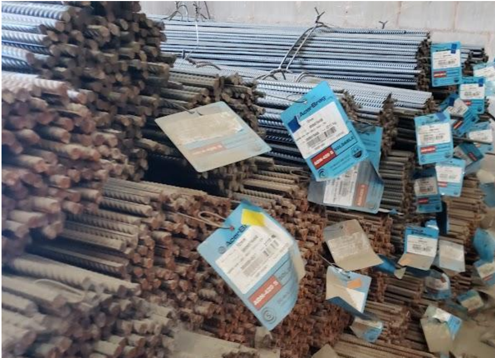
Imagen 25: Lingadas de varillas de acero
