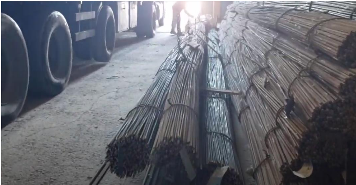
Imagen 22: Acopio de varillas con maderas
