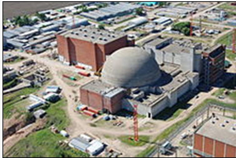
Figura 23: Central nuclear Atucha II Fuente: Nucleoeléctrica Argentina S.A.
